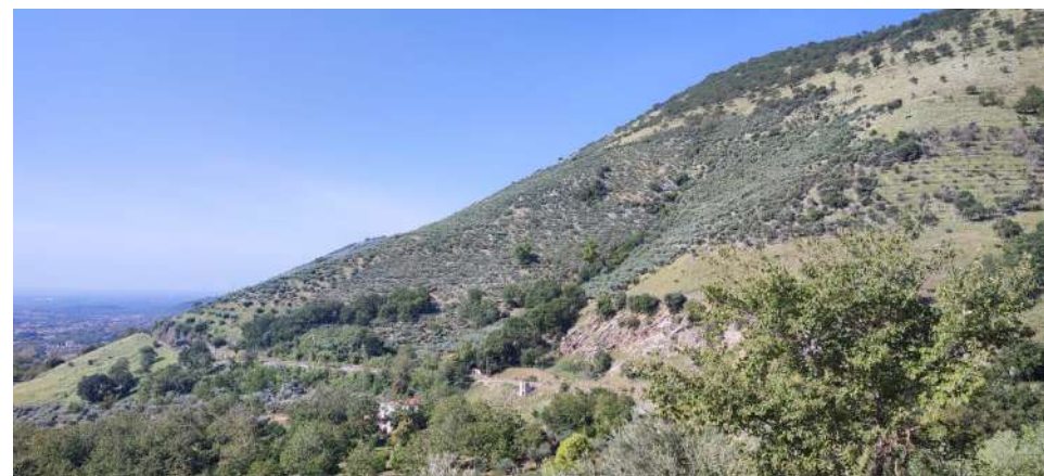
FIGURA 4-3 - VEDUTA DI UN VERSANTE INCISO DAL TRACCIATO FERROVIARIO IN CUI NON SI RISCONTRA LA PRESENZA DI FENOMENI GRAVITATIVI
